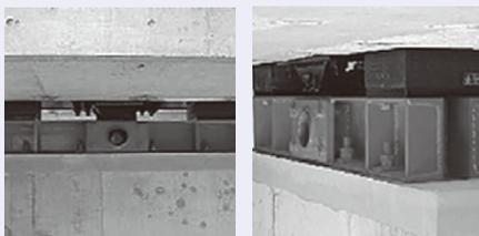
愛知工業大学で開発した鋼管ねじりダンパーと積層ゴムを組み込んだ免震ゴム支承装置。
